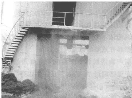
图 1-1 邢台矿电厂粉煤灰装车现场
