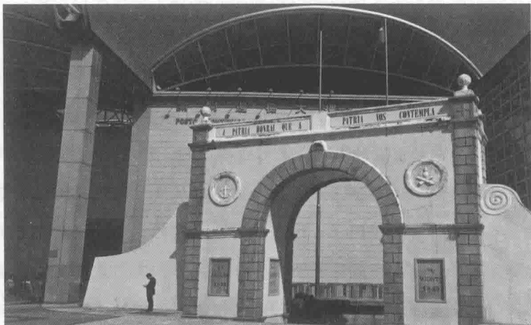
■澳门边检大楼旁的黄色拱门
