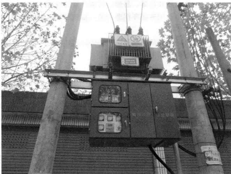
图 1-4 杆架式油浸配电变压器
