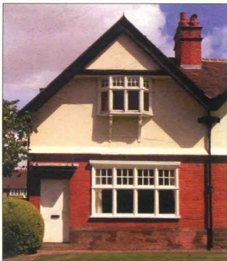
图1.3：一座工艺美术风格的后式联排房，是工人住宅区的一部分，其形状、轮廓和装饰均由当地一位建筑师设计。注重抹灰混合、砖石和装饰性的雨水斗。
