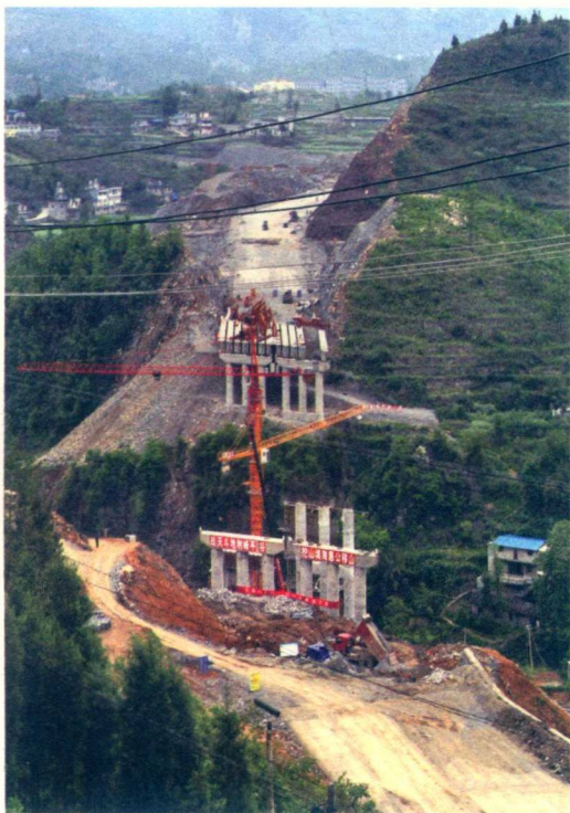
建设中的正安至安场快速通道大桥
