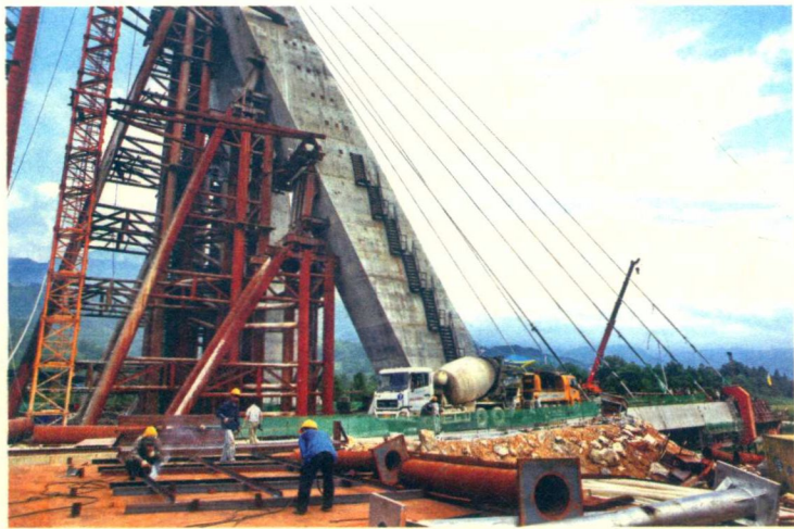
建设中的高速公路大桥
