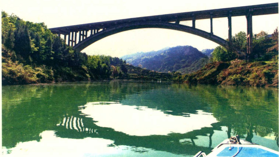
S207省道两河口大桥
