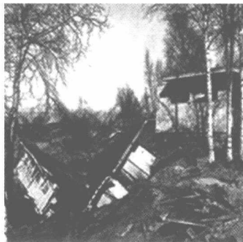
图 1.7 房屋倾斜倒塌
