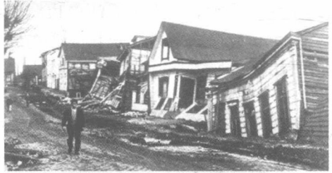
图 1.9 地震造成的房屋倒塌
