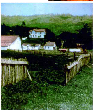
跨圣安德烈斯断层的篱笆在1906年旧金山地震之后发生3~4m的错动（右旋）（来源：Robert E. Wallace, USGS ; G.K.Gilbert, USGS）
