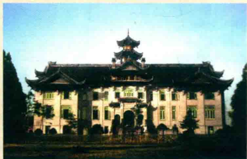
刚竣工的万德堂
