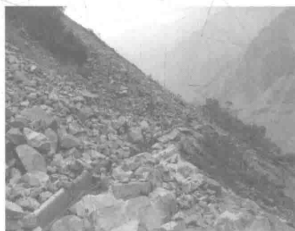
d) 崩塌落石掩埋道路
