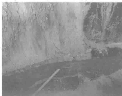
e) G213彻底关大桥右侧斜坡崩塌砸毁桥梁
