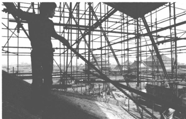
慈宁宫修缮工地
