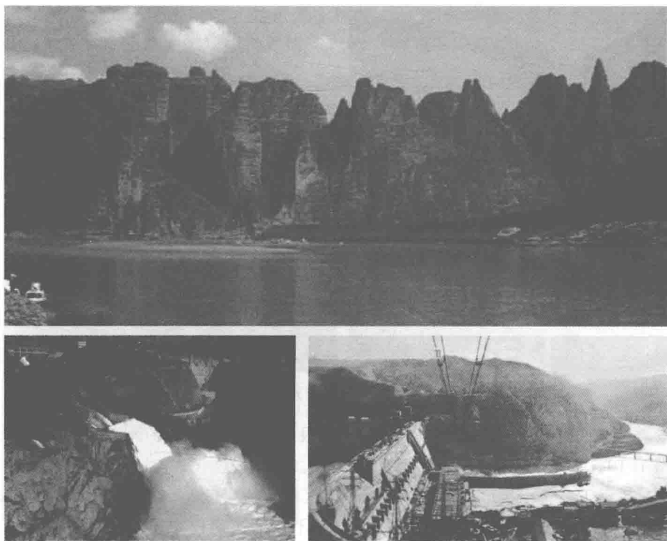
图 1.7 刘家峡水电站
