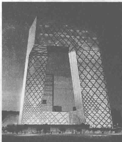
图1-1 房屋建筑工程
