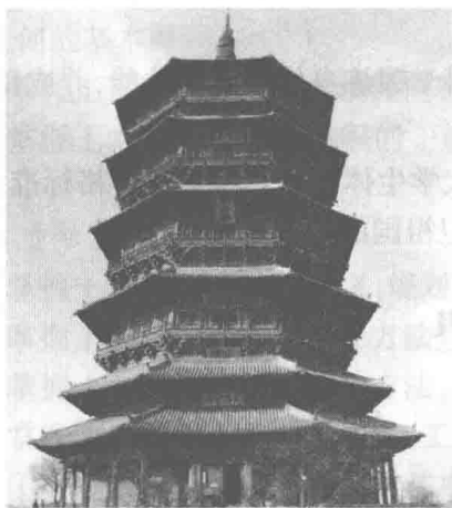
图 1-9 山西应县木塔
