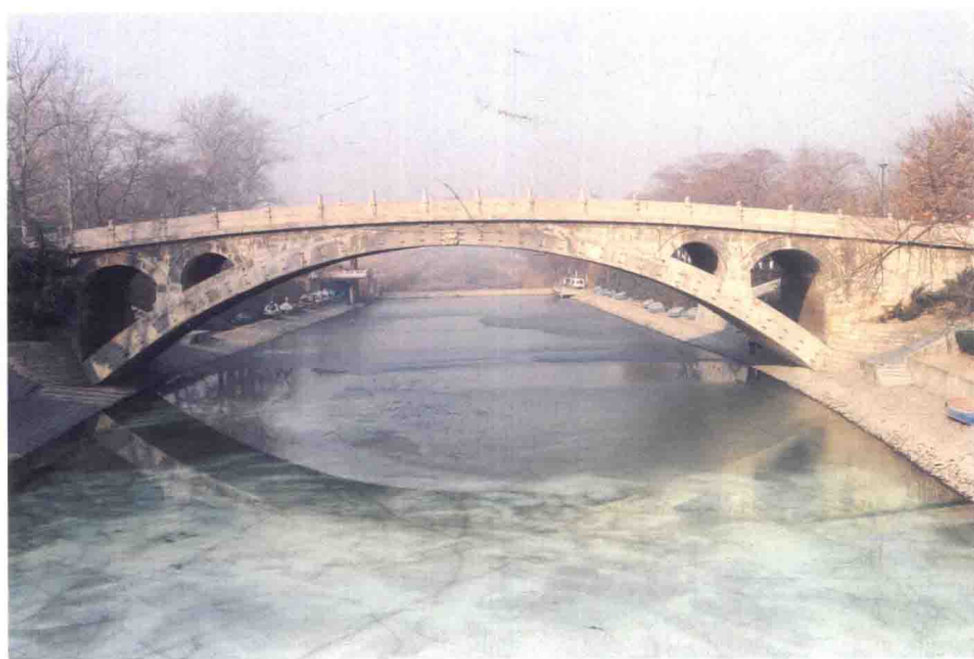
赵州安济桥——大石桥（姚峰拍摄）
