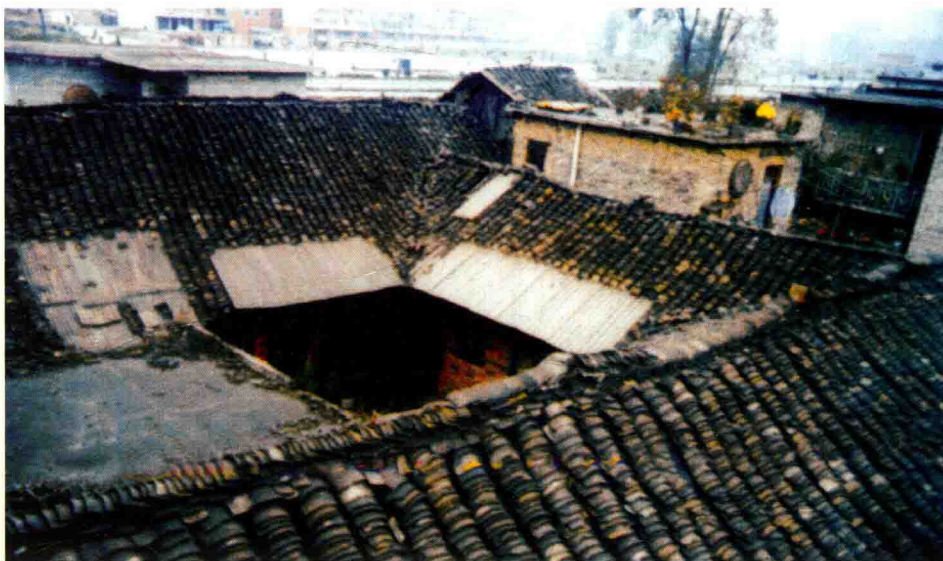
田君亮故居，位于老城解放路45号（2012年）
