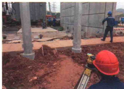
土建交安检查 (复核基础标高)
