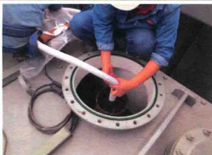
套管引线安装
