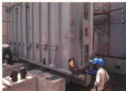
本体就位检查(变压器本体接地)
