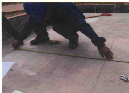
土建交安检查 (复核基础中心线)
