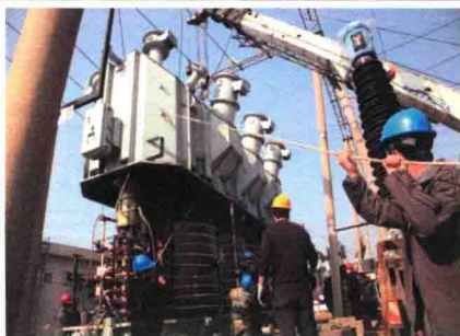
主变压器本体吊罩检查
