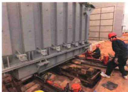
本体就位检查(检查千斤顶受力点是否在指定位置,轨道是否稳固)
