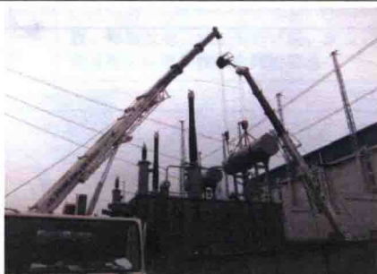
主变压器附件安装
