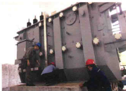
本体就位检查(就位后中心线复测)
