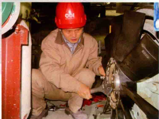
施工人员铆足干劲
