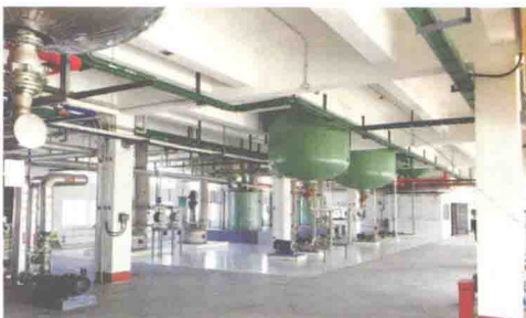
升级改造后的冀衡药业公司生产车间一角
