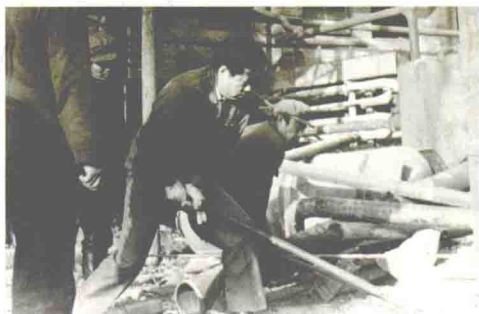
1987年10月，衡水地区化肥厂进行建厂以来的首次技改，新上氮肥1.5万吨合成氨项目，肖秋生与工人们同心协力奋战在工地。
