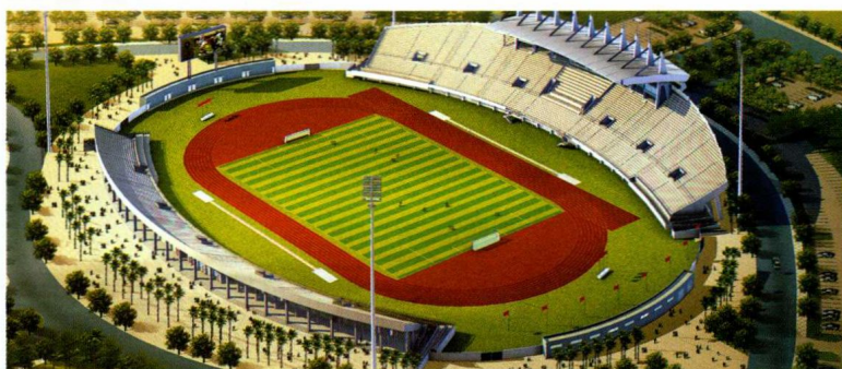
巴哈马国家体育中心扩声系统 Bahamas National Stadium centre sound reinforcement system
