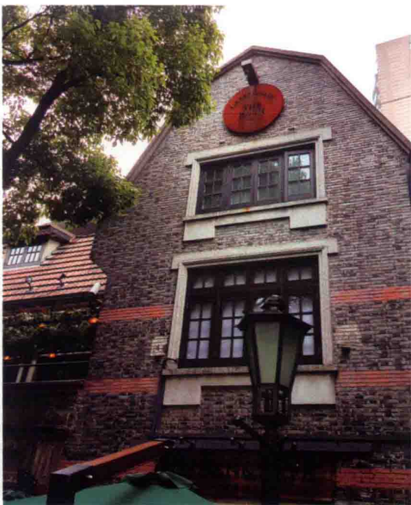
新天地敦仁里折坡屋面
