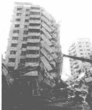
图 1-9 结构失稳引起的破坏
