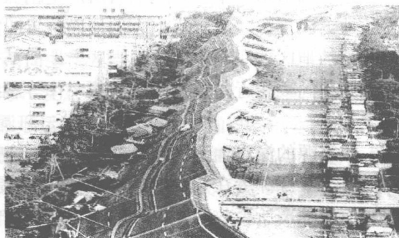
图 1-12 日本地震的桥梁的破坏
