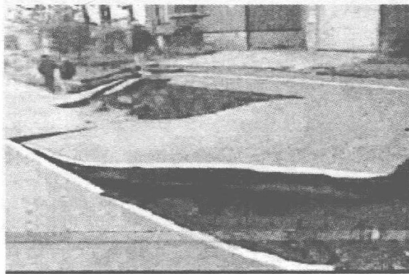
图 1-4 日本新泻地震后地路上地裂缝
