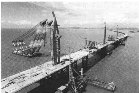
图 1-27 建造中的港珠澳大桥
