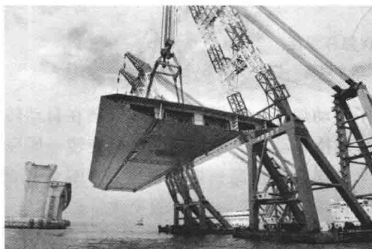
图 1-36 钢箱梁海上吊装
