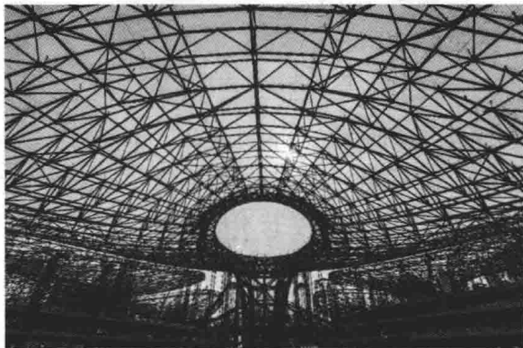
图 1-2 北京新机场的局部网架结构
