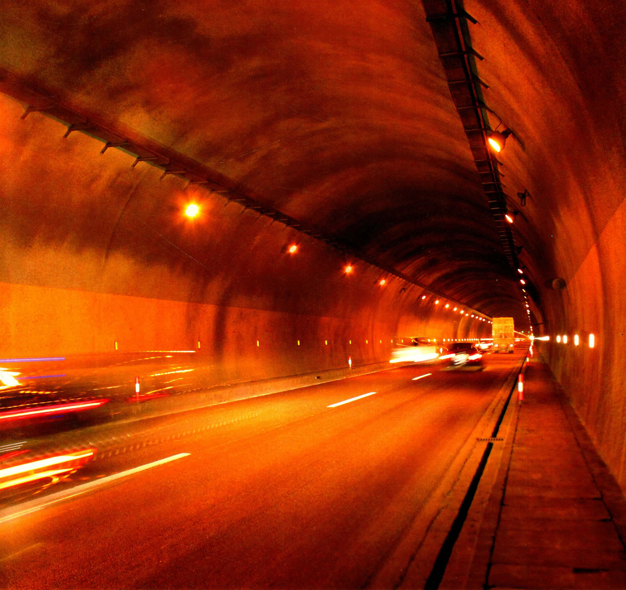
| 兰海高速公路崇溪河至遵义段凉风垭隧道
