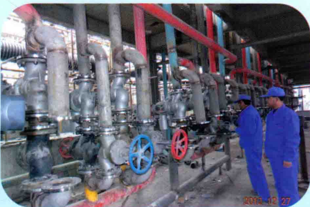
江华公司硫化钡技改项目
