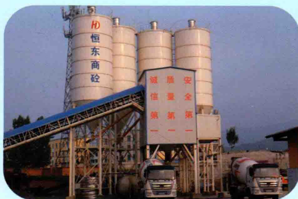
恒东年产20万立方混凝土生产线
