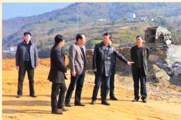
区长王孝成在大河镇金仓社区检查交通设施建设情况。
