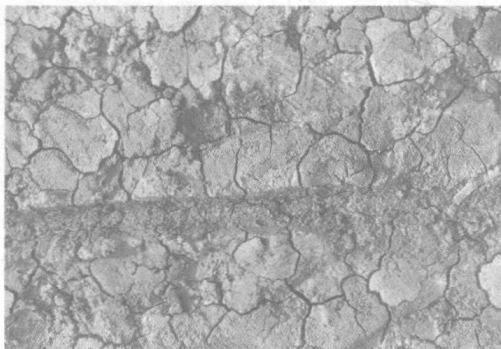
图 1-6 黏性土的龟裂
