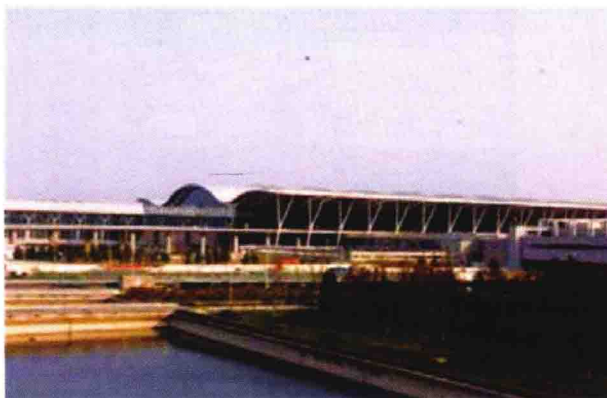
图 1-10 浦东机场二期航站楼楼屋面外板
