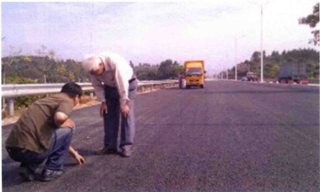
2011 年在广东增城石屑封层应力吸收层的施工现场
