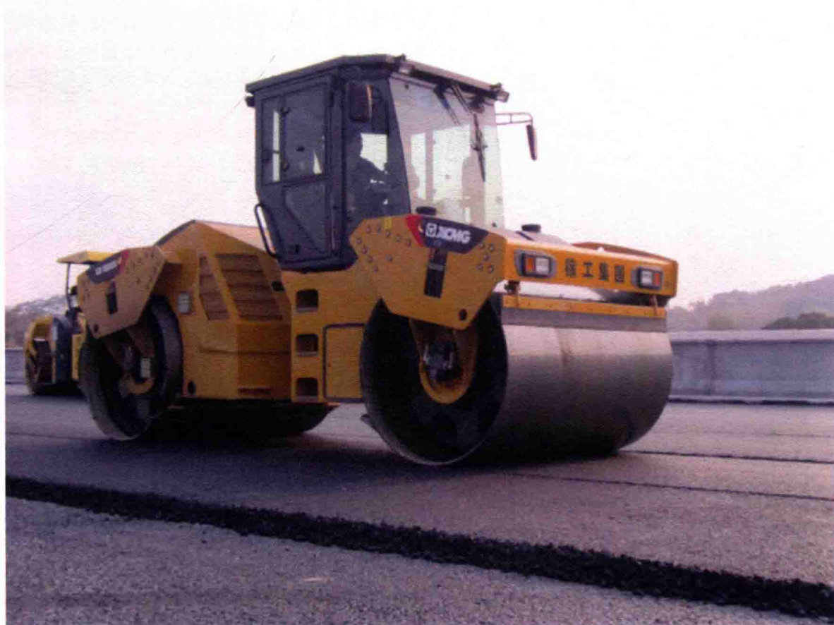
2014 年与徐工合作开发的 XD1320S 大吨位振荡压路机在广东高速花东段工地进行现场试验
