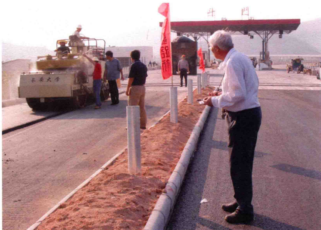
研究生马学良博士论文的试验研究工作于 2007 年利用振荡压实试验样机在广东斗门工地进行
