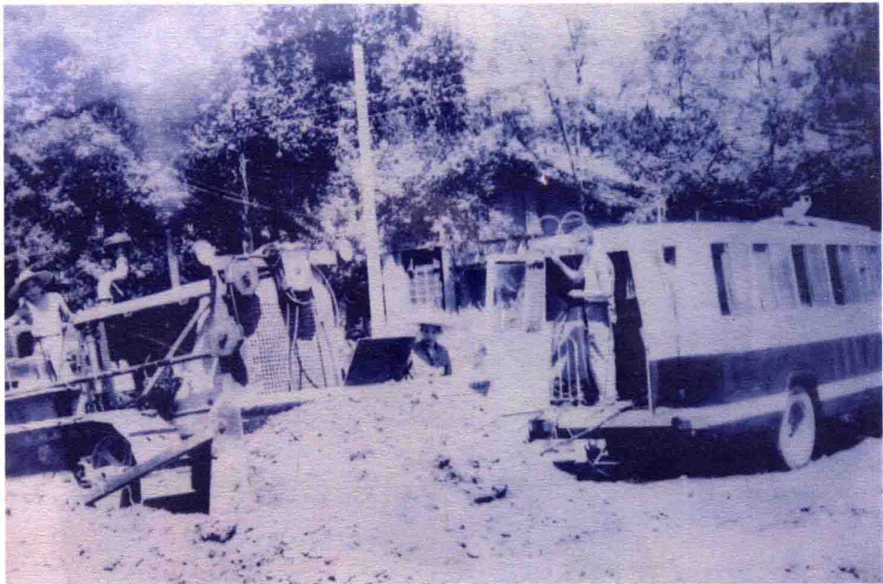
在学校试验场上进行推土机动态牵引性能的试验
