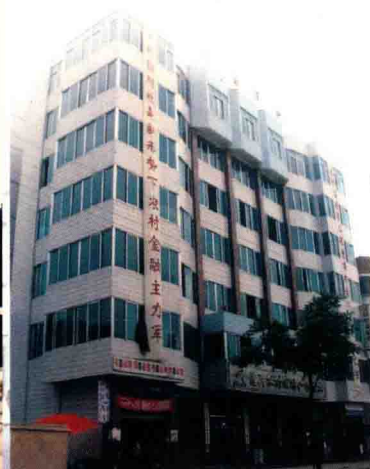
道真县联社办公楼
