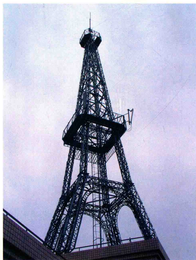
移动通信基站
