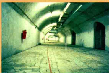
地下人防工事
