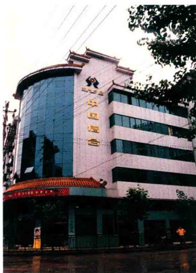
务川县联社办公楼
