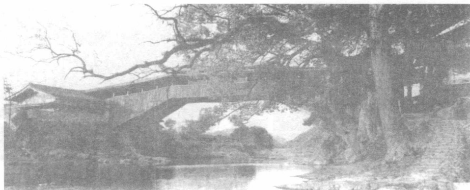
图 1-15 浙江泰顺廊桥
