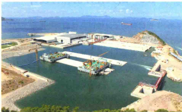
图 1-2 港珠澳大桥沉管隧道预制总览
