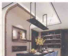
• 弧形石膏板+不锈钢条+灯带
