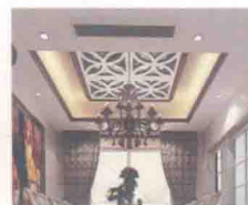
• 实木装饰线回字造型+错层石膏板+壁纸+石膏板雕花
