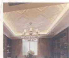
• 方形错层石膏板+石膏板井字格造型+灯带
