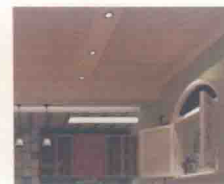
• 白松木扣板平顶造型+石膏装饰横梁
