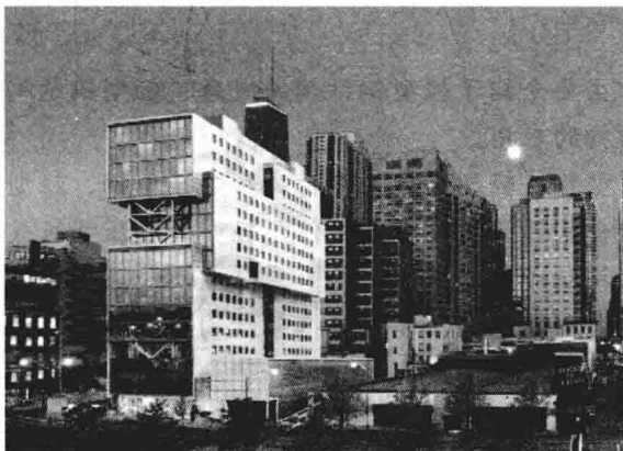
图 1-9 交错钢桁架结构的美国芝加哥斯桥公寓式酒店外观及桁架示意图
