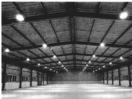
图 1-5 钢结构门式刚架厂房内景
