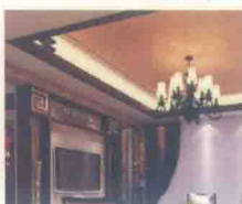
• 龙骨+方形错层石膏板+金箔壁纸+灯带+实木饰面板
