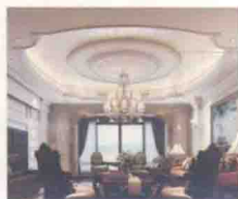
• 龙骨+异形跌级石膏板+灯带+金箔壁纸+石膏板浮雕
