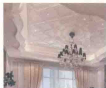
• 龙骨+异形错层石膏板+灯带+石膏板浮雕
