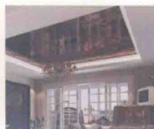
• 龙骨+车边茶镜+方形错层石膏板
