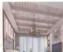
• 龙骨+石膏板错层+白松木扣板+实木横梁
