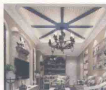
• 龙骨+圆角弧形错层石膏板+白松木扣板+实木装饰横梁
