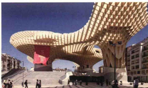
图1-3 塞维利亚市阳伞形态的建筑
