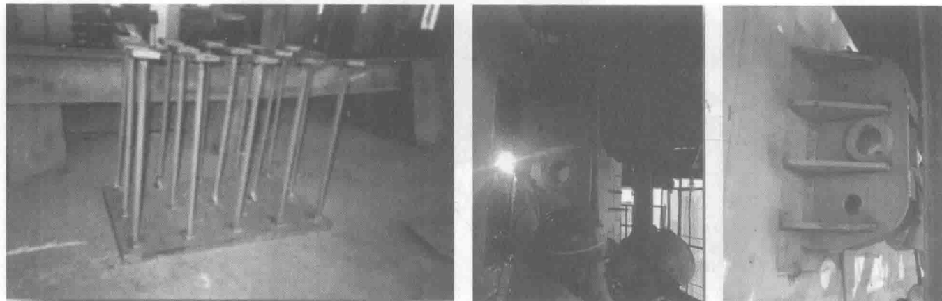
图 10 传统附着施工图片
