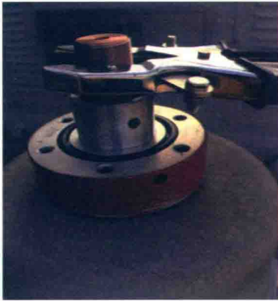
图 2 测试线直接接到接线座上
