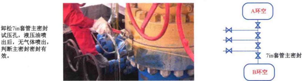
图 1.4 XX2-22 井 7in 套管主密封检查
