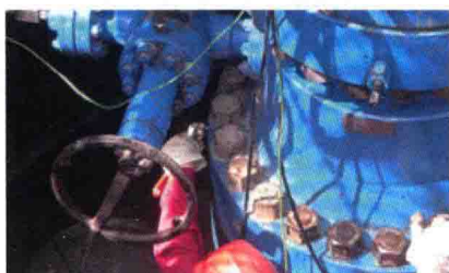
图 1.6 XX2-22 井 13\frac{3}{8} in 套管密封性检查
