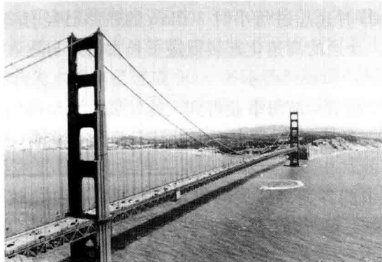
图 1-2 金门悬索大桥
