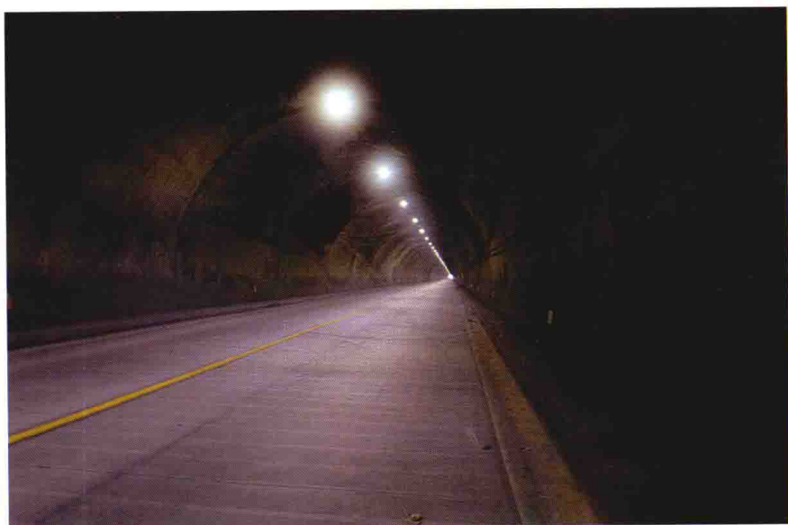
1988年1月交通部在临海召开《公路隧道设计规范》编写会议,图为被作参考依据之一的黄土岭隧道。
