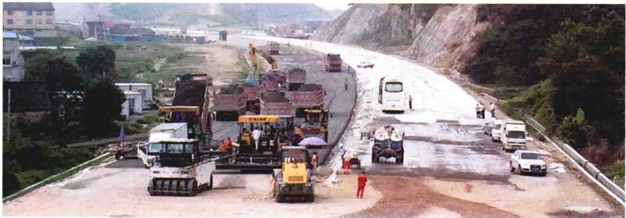
新83 公路工地现场
