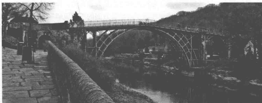
图1 位于英格兰科尔布鲁克代尔赛文河上的铁桥 (来源: https://www.designingbuildings.co.uk/wiki/The_Iron_Bridge )
