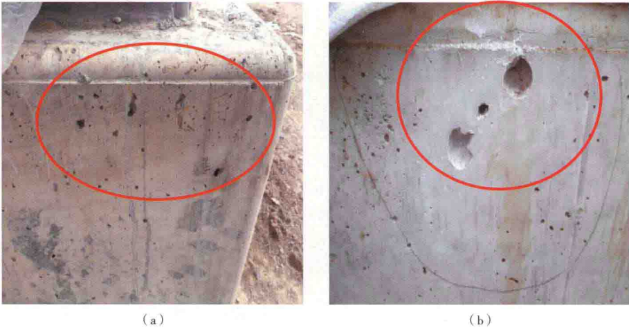
图 2-3 基础沙眼、气孔
