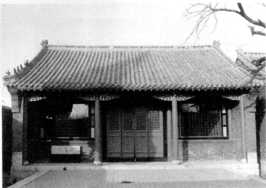
临胸状元祠正厅外景(坐落于朱位村中,建于明万历年间。 马庆洲 2013 年 12 月摄)
