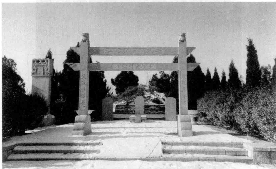
临胸状元林外景(地处朱位村西南高冈。陵园原占地 100 多 亩,满园苍松翠柏;墓前碑碣森然,石像惟妙惟肖。“文革”中惨遭 毁坏,今为复建。马庆洲 2013 年元月摄)
