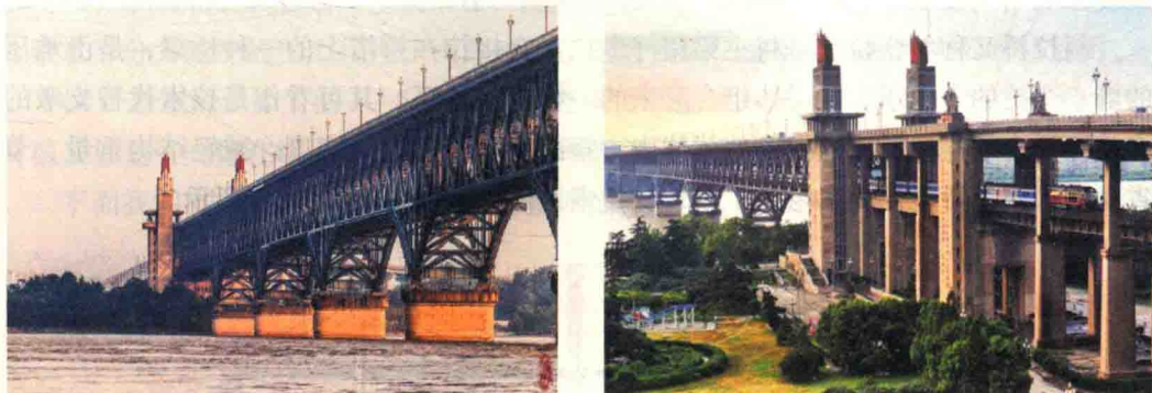
图 1-2 南京长江大桥及引桥
