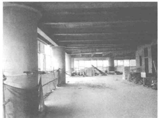
图 1-4 圆钢管混凝土柱
