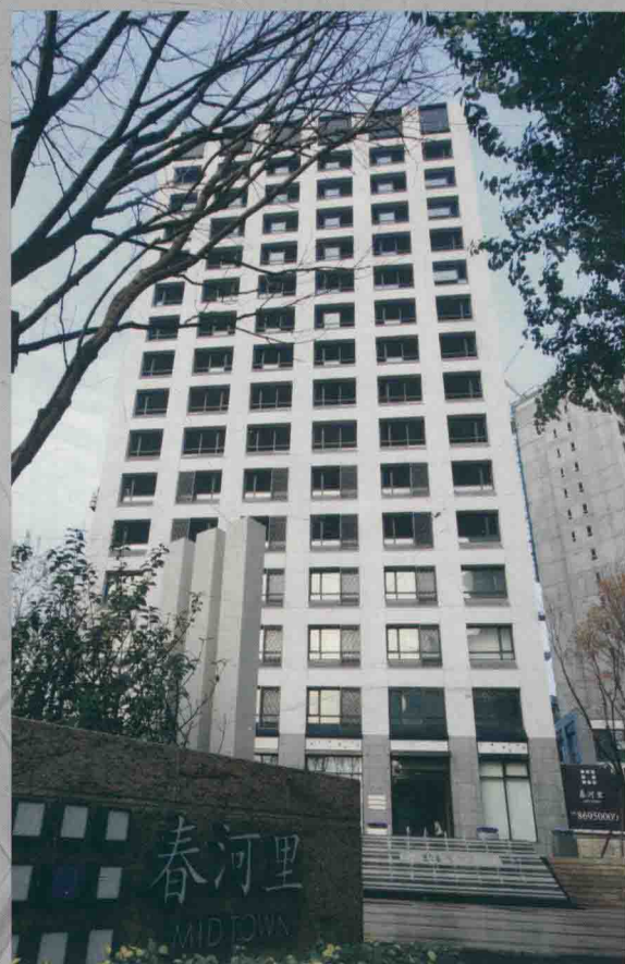
图 C04 沈阳万科春河里 17 号楼 —— 框剪结构高装配率高层住宅 (万科沈阳公司提供)
