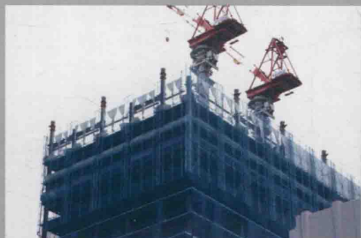
图 C10 日本某钢结构施工工地
