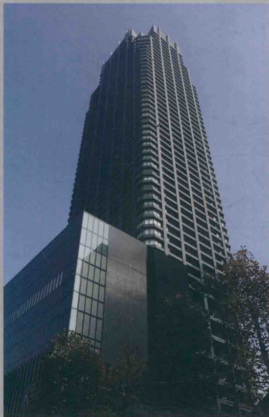
图 C01 日本大阪北滨公寓 —— 世界上最高的装配整体混凝土建筑 (208m)
