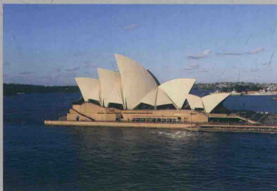
图 C02 悉尼歌剧院 —— 曲面造型的装配式混凝土建筑
