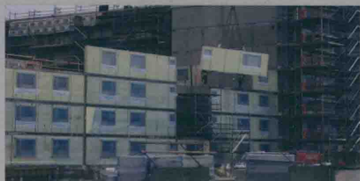
图 C11 装配式木结构整间墙板
