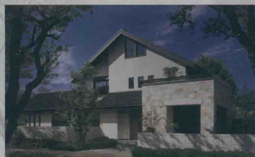
图 C09 日本积水公司建造的别墅 —— 在流水线上 造出的钢结构+轻质水泥墙板装配式建筑
