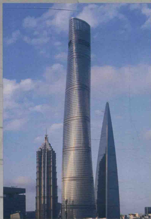
图 C07 上海中心大厦 (632m) —— 国内最高的 巨型钢框架—钢筋混凝土核心筒结构大厦
