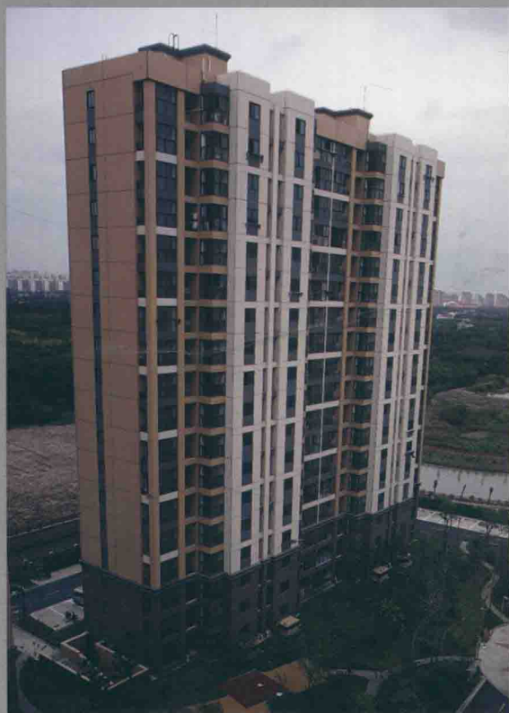
图 C05 上海浦江保障房 (国内应用范围最广的剪力墙结构住宅)
