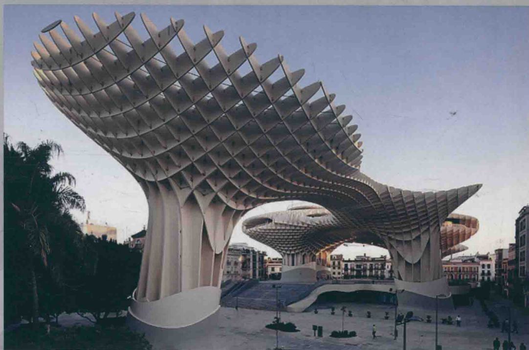
图 C13 西班牙塞维利亚都市阳伞 —— 世界上最大的木结构装配式建筑
