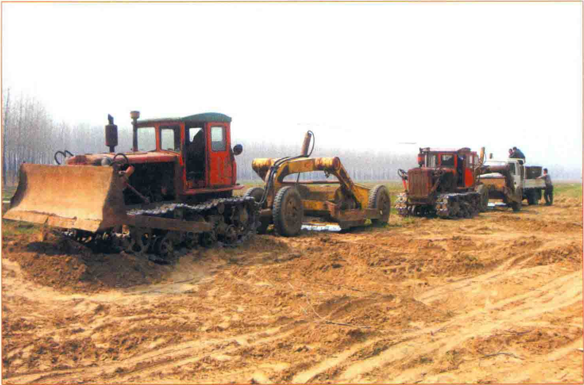
2009年11月，铜山区大彭镇土地开发整理项目施工现场
