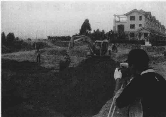
图 1.3 土木工程勘测
