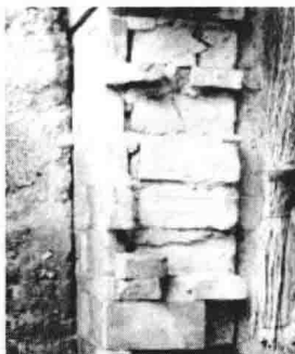
图 1.1.7 包青墙体断面
