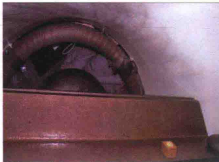
图 2-6 均压环位置的放电痕迹
