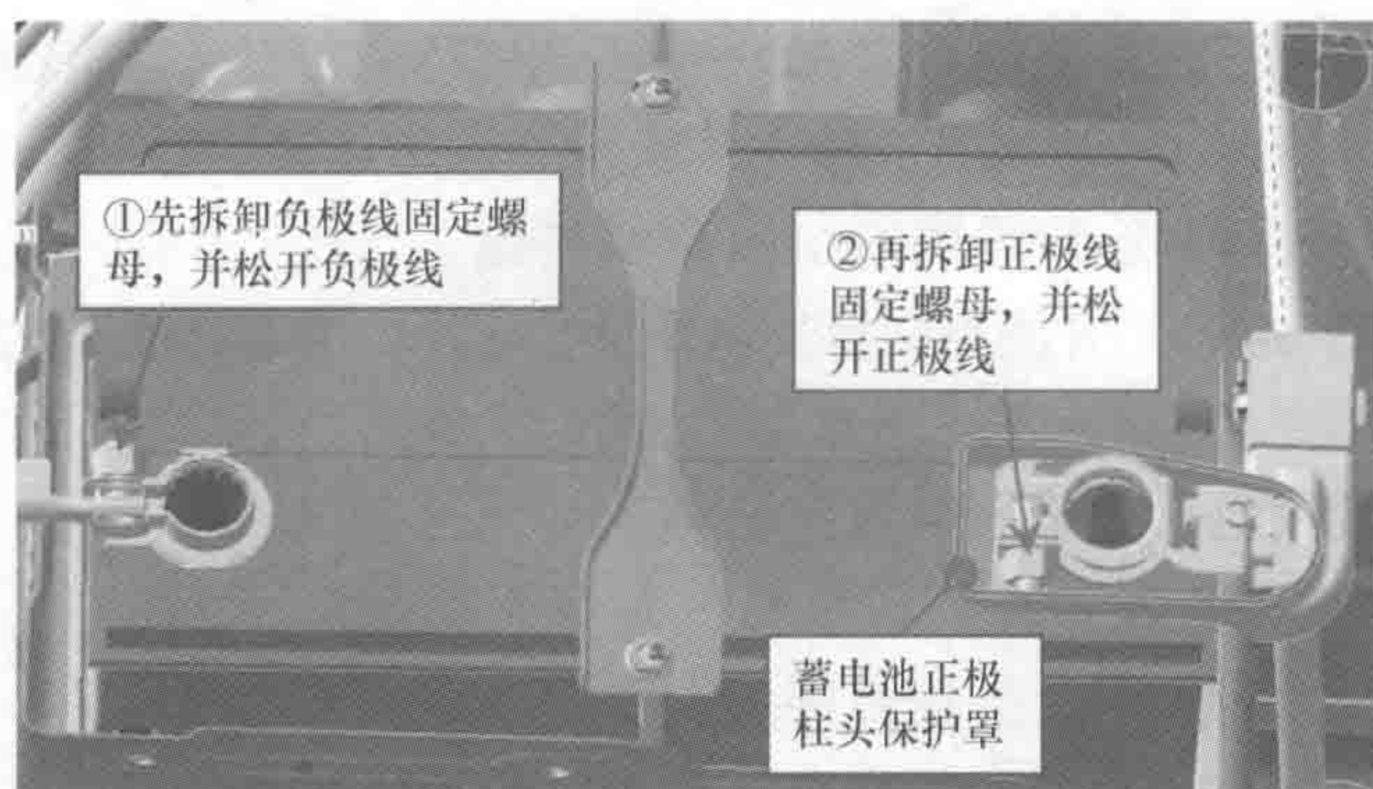
图 1-7 断开蓄电池接线柱
