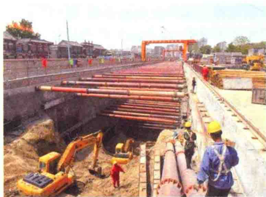
图 1-8 地铁车站明挖法
